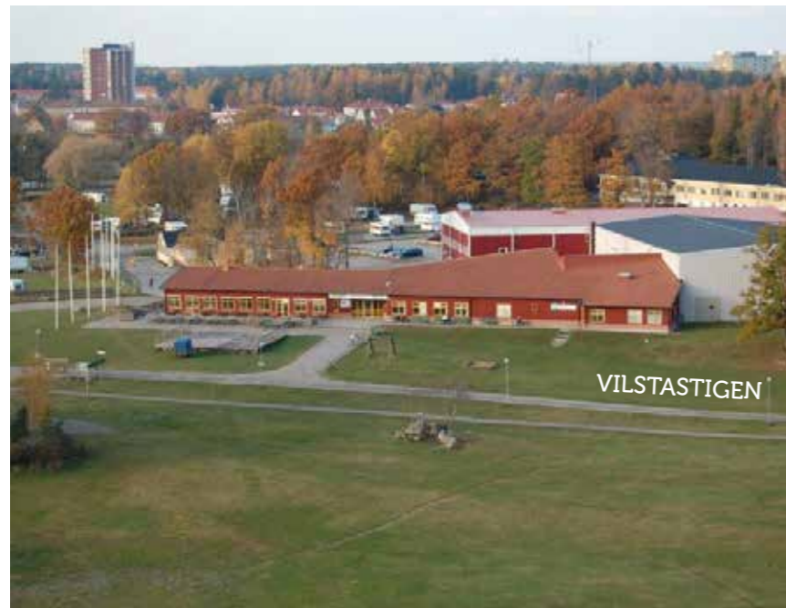
Huvudentrén till Vilstastugan vänder sig mot slalombacken. Man angör dock huvudsakligen byggnaden från baksidan.
