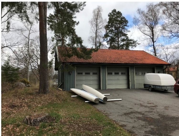
Trippelgaraget. Poolhuset kan anas i högerkanten.
