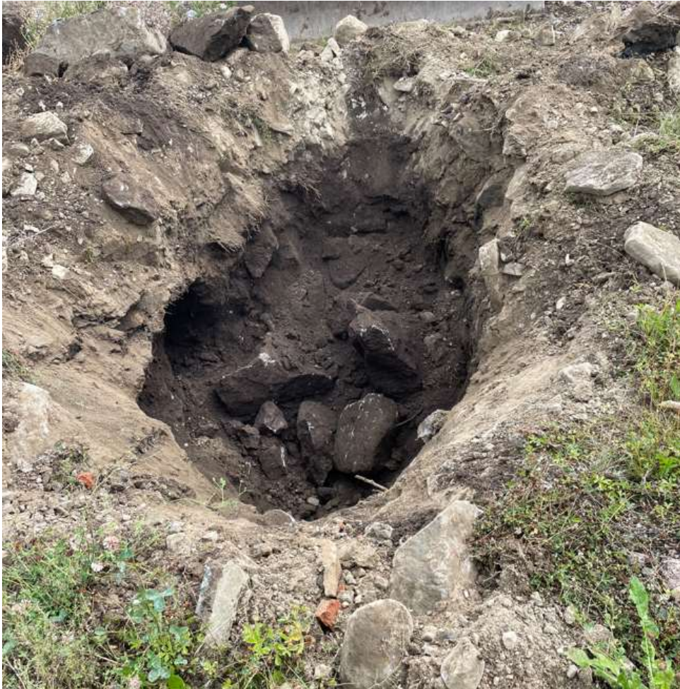
Figur 4.4 Exempel på provgrop för provtagning i delområde Fyll-1 – Fyll-4.
