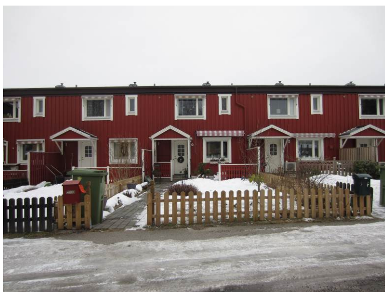
Utformningen av husen är homogen, färgsättningen skiljer sig mellan de olika raderna av hus.
