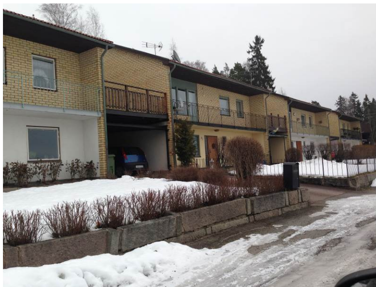
Kedjehus i souterräng, exempel från Kamhagsvägen.
