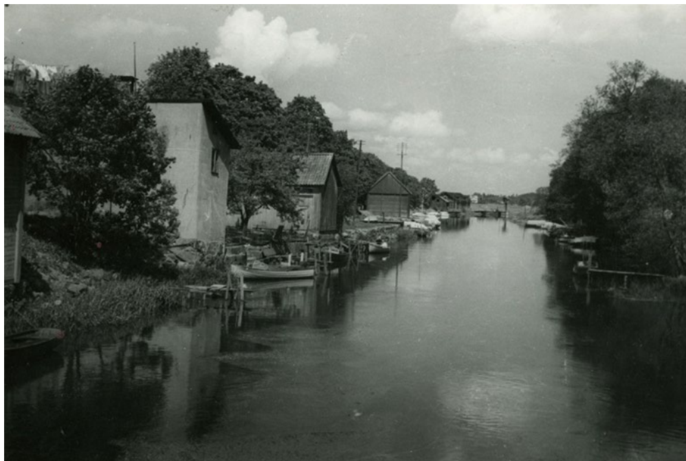
Figur 14. Foto från 1947 i Torshälla hamn. Hammagasin som bevarats och idag utgör befintlig servicebyggnad syn på bilden. Foto: Lars Erik Ranngård.
