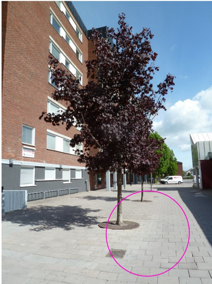
Figur 8. Lågpunkten vid Skogsängens centrum (Skogsängsvägen 2-4) är väl avvattnad med flera dagvattenbrunnar.
