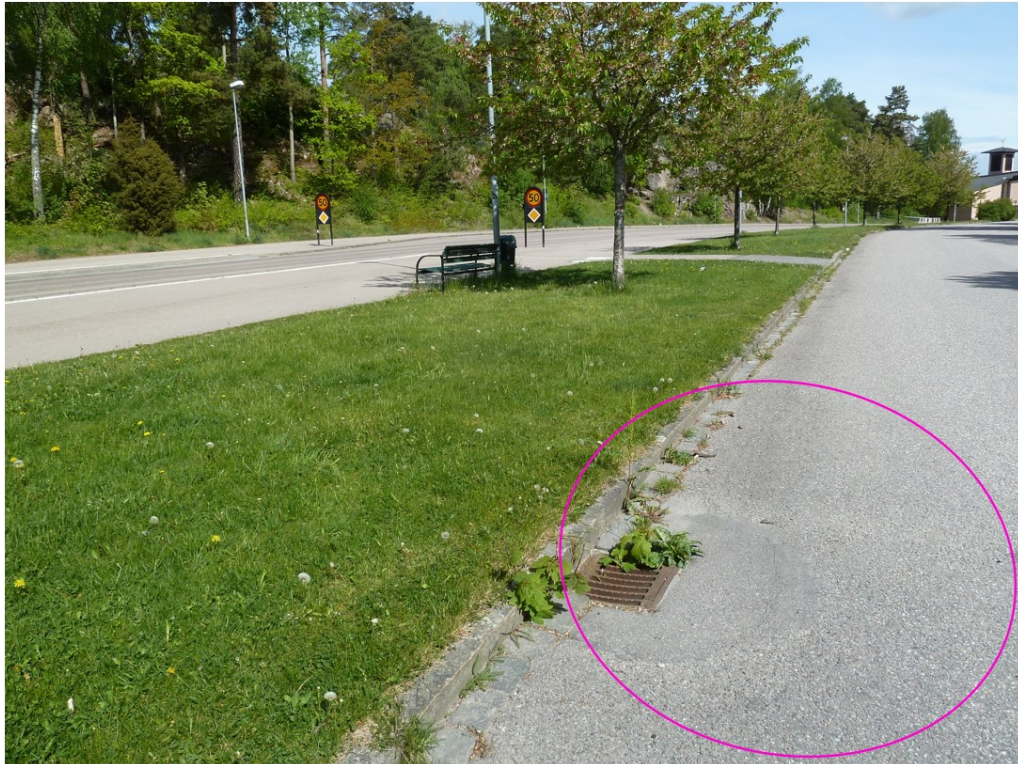
Figur 7. Lågpunkt 1 på Carl-Johansgata i delavrinningsområde A1. Det finns idag en dagvattenbrunn i lågpunkten. Se även kantstenet mot grönytan som förhindrar dagvatten från att nå dit.
