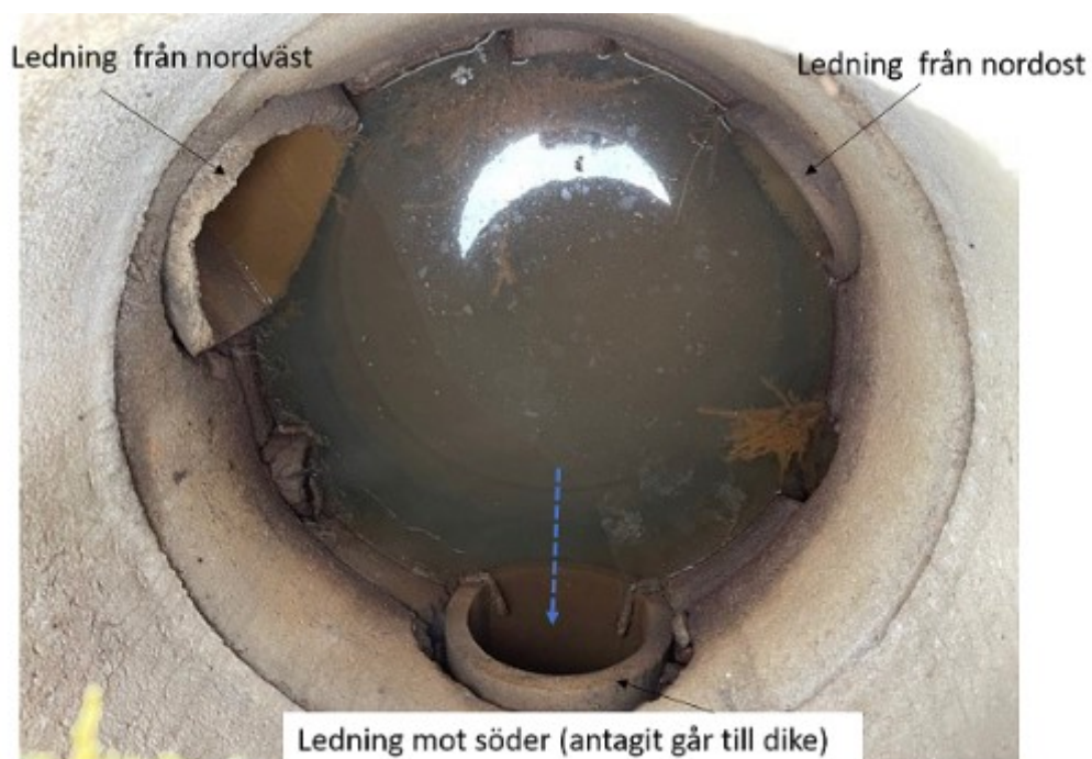
Figur 12. Dagvattenbrunn 2 (Figur 10) inom planområdet tar emot vatten från 5 ledningar och leder det vidare söder ut mot diket. Foto: WRS (2021-04-19).
