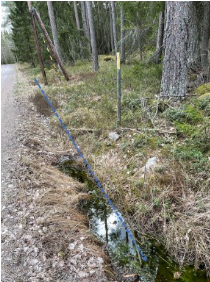
Figur 13. Befintligt dike vid Fasanvägen Foto: WRS (2021-04-19).
