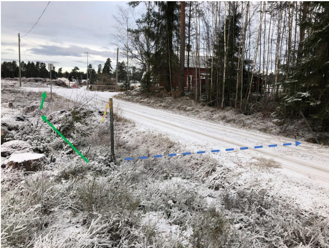
Figur 13. Utströmning från Våtmark 2 under Fasanvägen som sker mellan två metallrör (blå streckad pil) och placering av skyddsåtgärder i dike vid förläggning av eventuella ledningsgravar (gröna pilar). Se även Figur 15 senare i rapporten.
