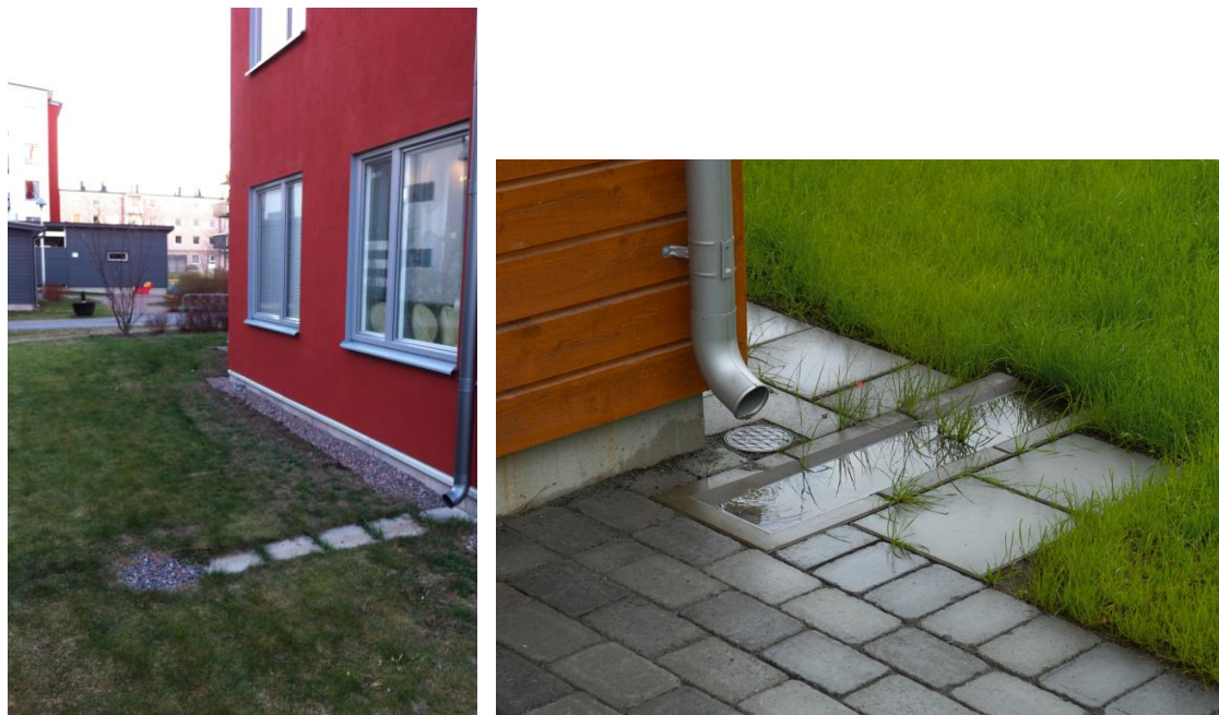
Figur 12. Exempel på takvatten som avleds via rännal till mindre stenkista respektive gräsmatta. Foto WRS (tv), www.steriks.se (th).
