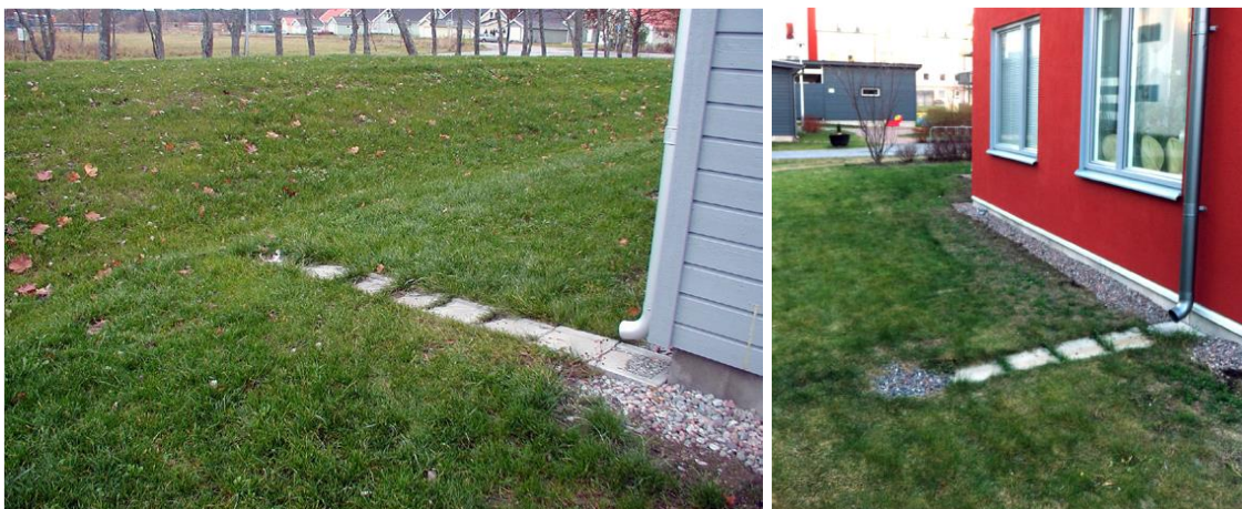
Figur 14. Två alternativ för att avleda takdaggvattentill en grönyta för infiltration. I bilden till höger leds vattnet till en liten stenkista i grönytan.
