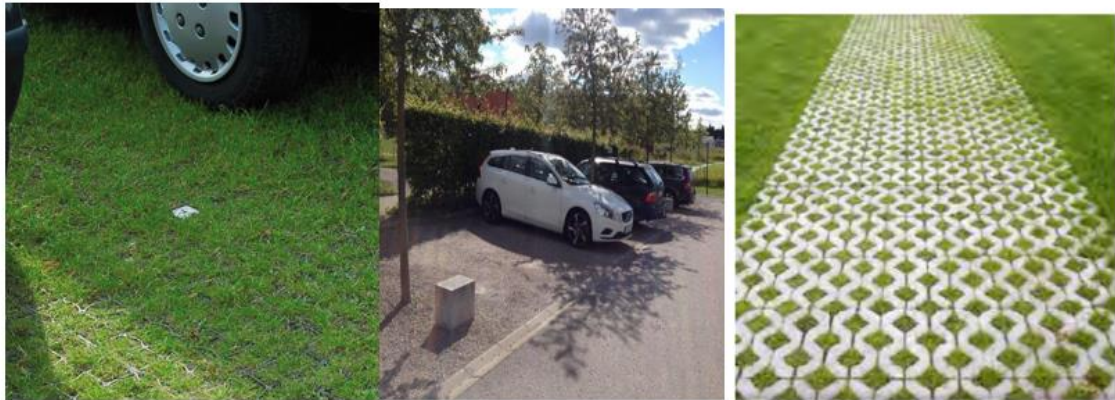
Figur13: Olika typer av permeabel beläggning på parkeringsytor
