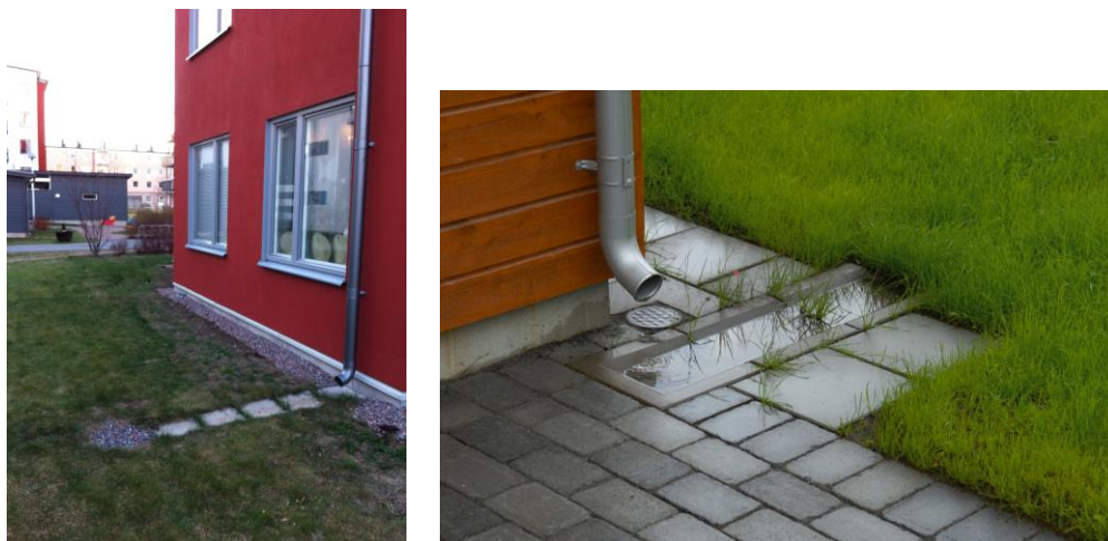
Figur 15. Exempel på takvatten som avleds via rännal till mindre stenkista respektive gräsmatta. Foto WRS (tv) och www.steriks.se (th).
