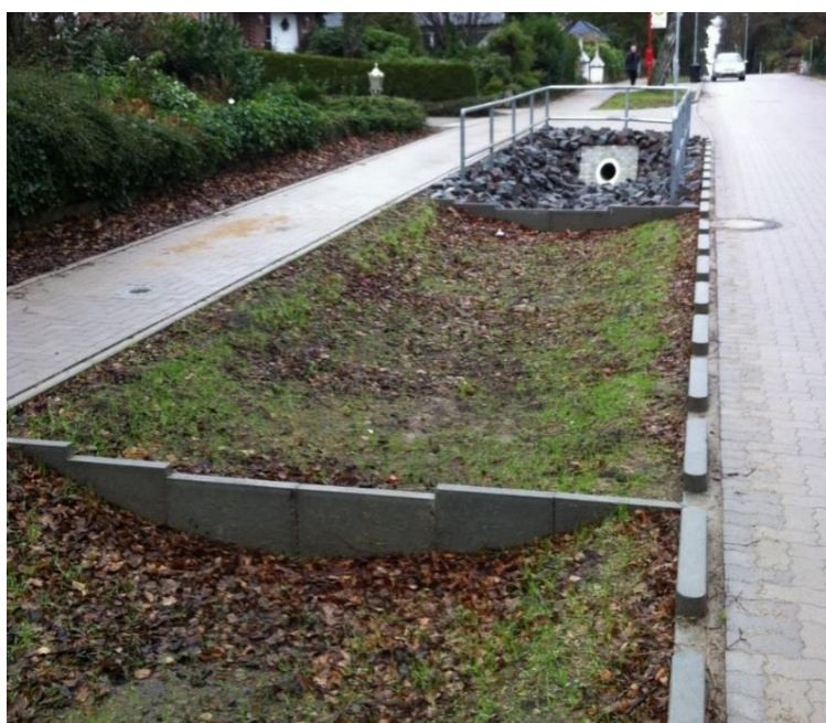
Figur 35. Svackdike med inbyggda dämmen som bildar sektioner i diket. Foto: WRS.
