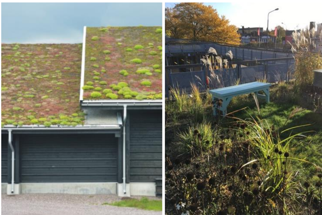
Figur 20. Exempel på tunna (till vänster) och tjocka (till höger) gröna tak.
