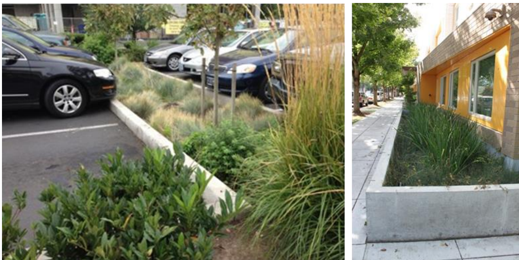
Figur 22. Bildexempel på nedsänkt eller upphöjd växtbädd i anslutning till parkeringar eller längs en husvägg.
