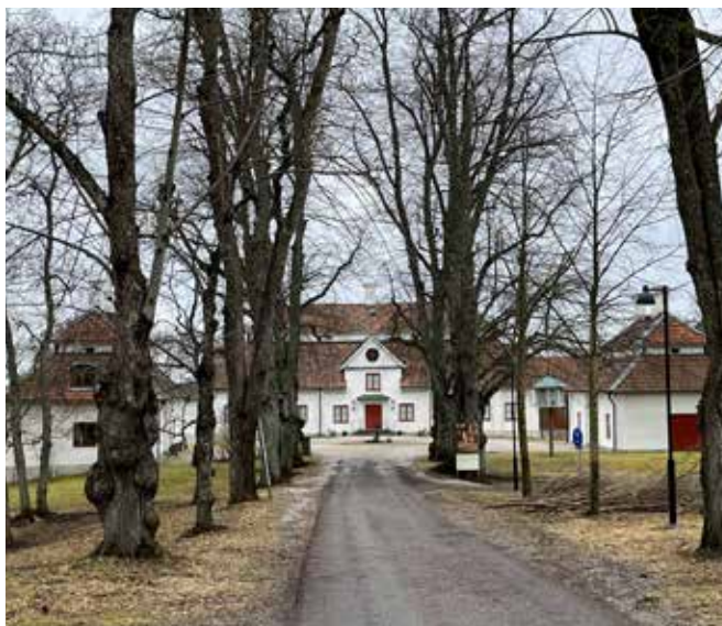
Mangårdsbyggnad med flyglar samt allé.
