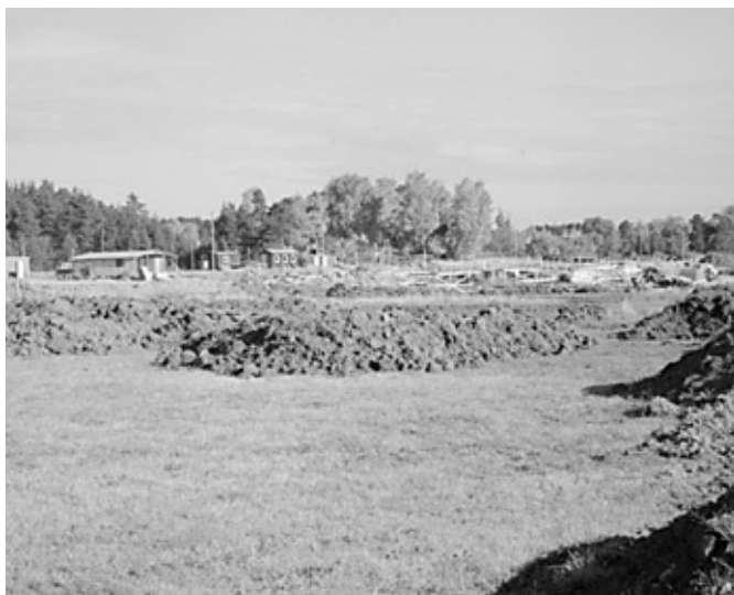
Byggarbetsplats vid Myrtorp, ett närliggande bostadsområde som anlades några tidigare än Lagersberg. Foto: Bror Öbrink, Eskilstuna stadsarkiv
