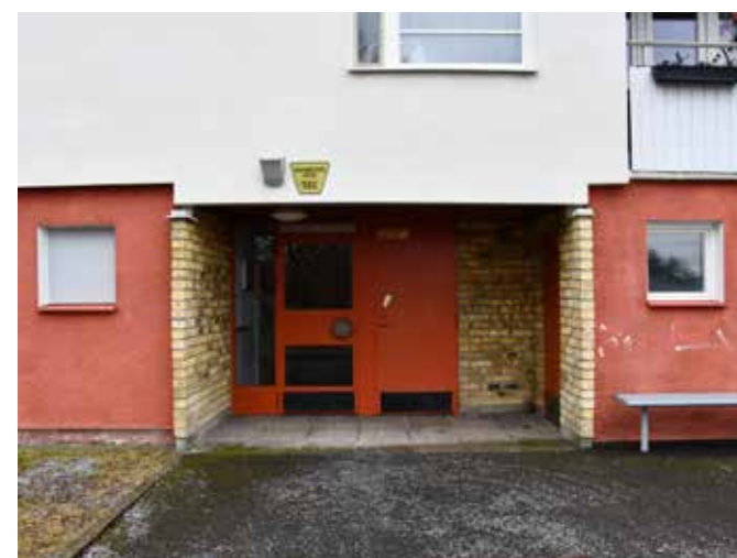
Entrédörr med originaldetaljer.
