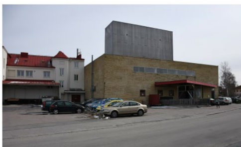
Del av kv. Verkstaden, placerad mitt emot fastigheterna Valnöten 14 och 6. Byggnaden har en högre uppskjutande volym som är betydligt högre än intilliggande byggnader.
