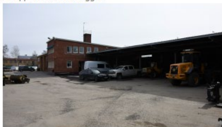
Valnöten 14:s garage och kontorsbyggnad fotat från gården.
