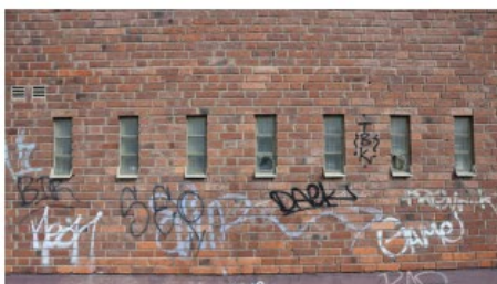
Detaljbild av Valnöten 14:s fasad mot Gredbyvägen med ljusinsläpp i form av betongglas.
