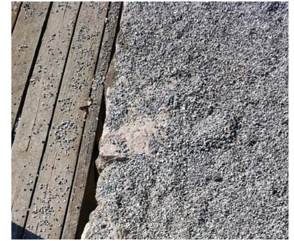
Det grövre gruset sprids ut och ligger på både granit och trä.
