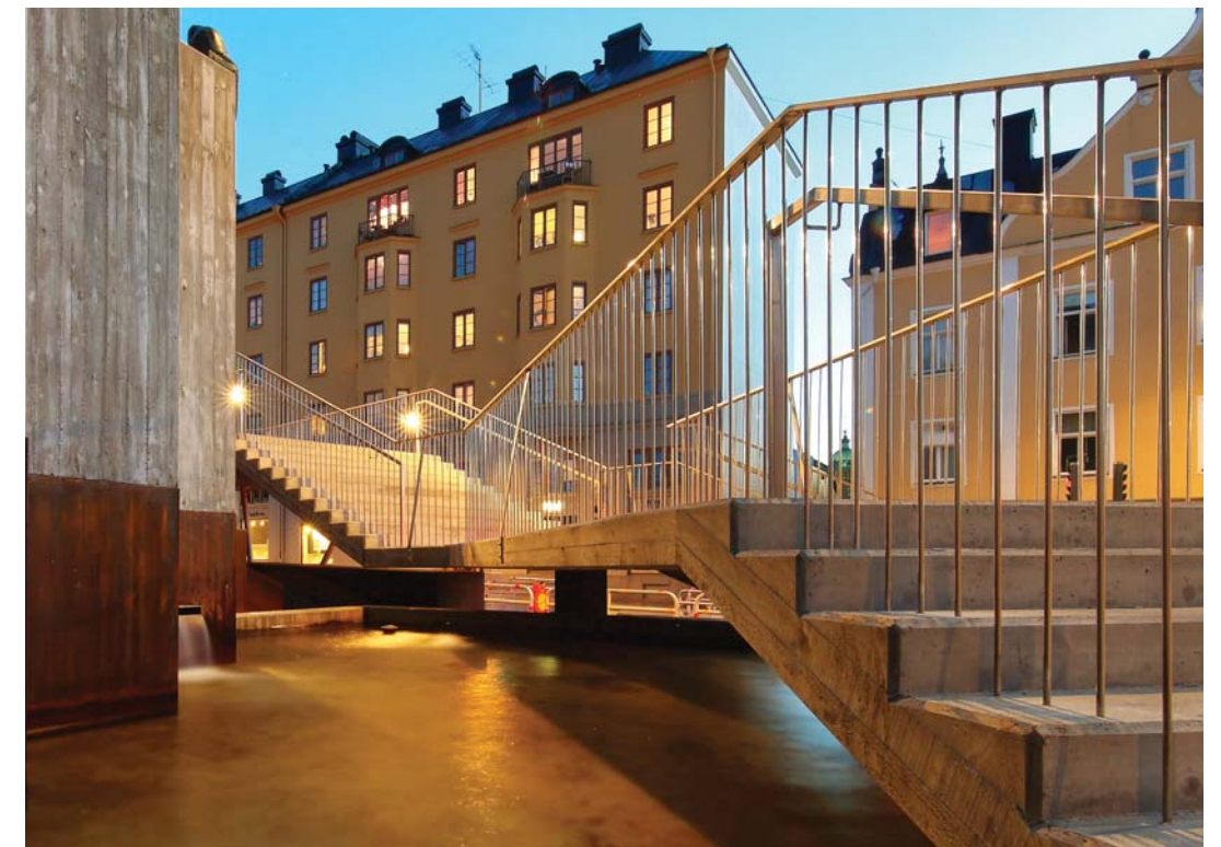
Rostfritt räcke på tunn betongkonstruktion.
