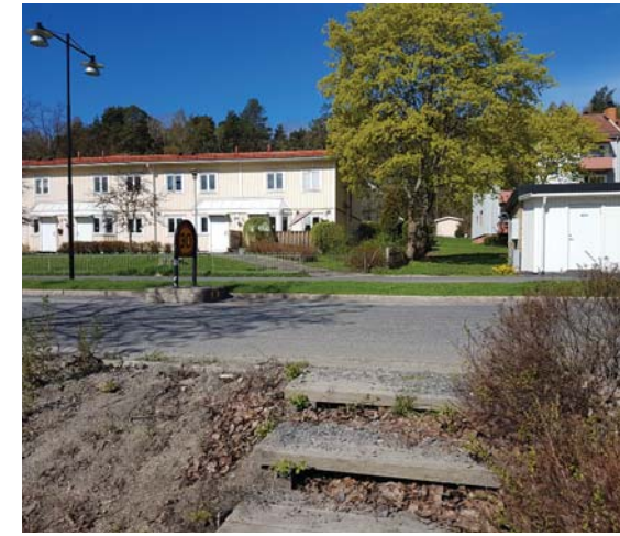
Befintliga trappor kopplar inte ihop delarna längre och leder rakt ut i biltrafiken.
