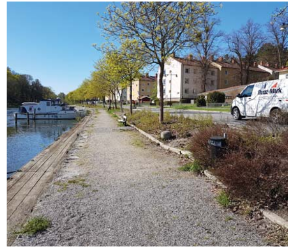
Eftersatt underhåll där kantstenar lutar och ogräset tar över.
