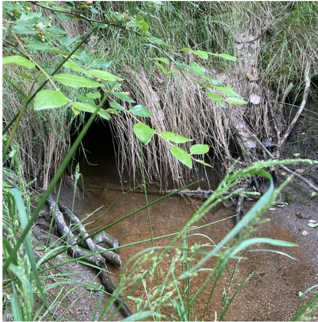
Figur 14. Utlopp av trumma under Västeråsvägen. Trumdiameter 1000 mm.
