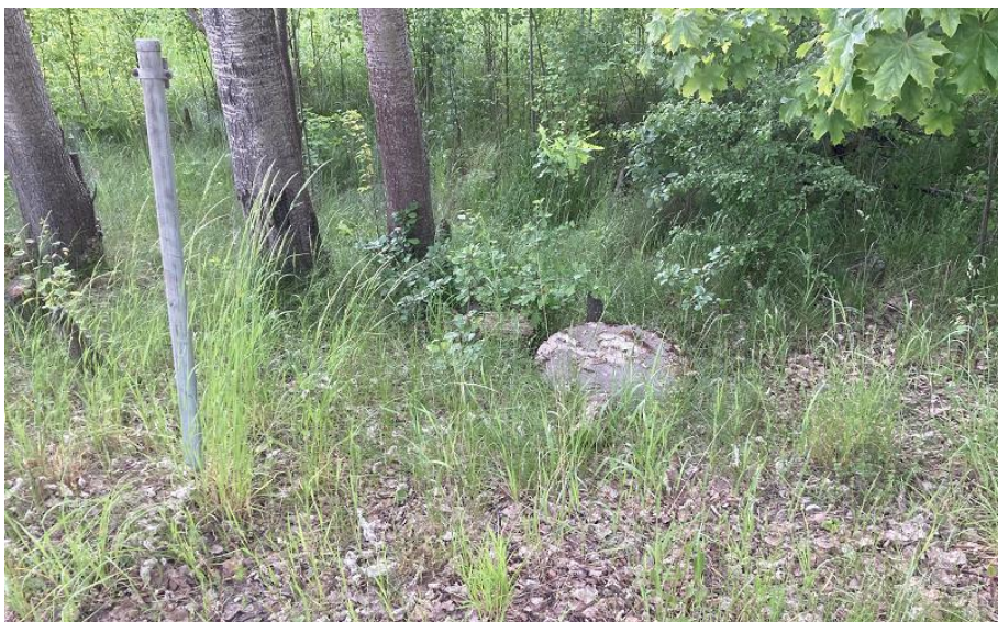
Figur 12. Fotoläge B, norrut. Nedstigningsbrunn på befintlig spillvattenledning.
