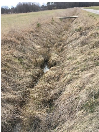
Figur 14. Vägdike vid punkt 7. Bild tagen mot söder.
