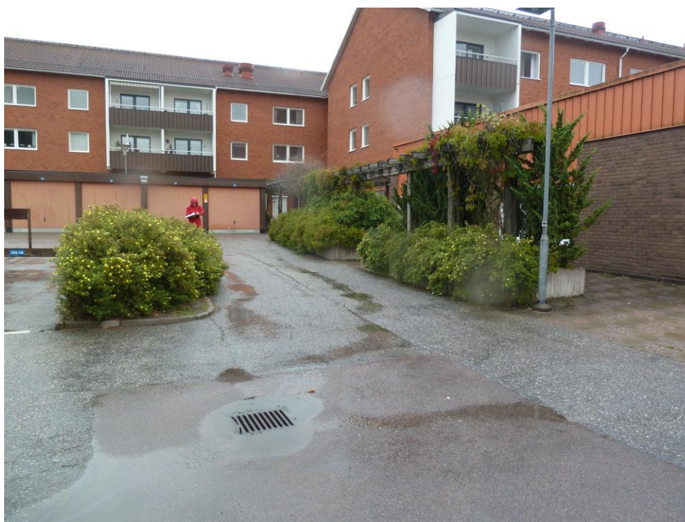
Figur 12. Lågpunkt med dagvattenbrunn på befintlig parkering och befintliga planteringar med små avrinningsområden.
