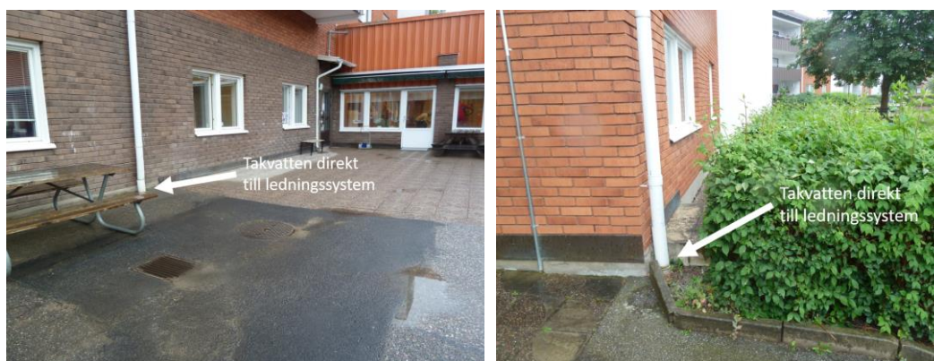
Figur 5. Takdagvatten inom planområdet som avleds direkt till ledningsnätet.
