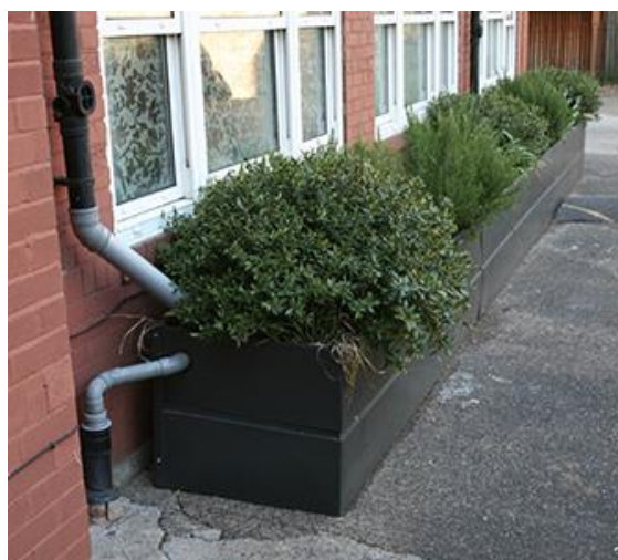
Figur 10b. "Modulregnbädd" för takvatten. Källa: Rent dagvatten.
