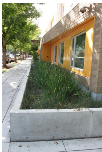
Figur 10a. Exempel platsbyggd regnbädd. Foto WRS.
