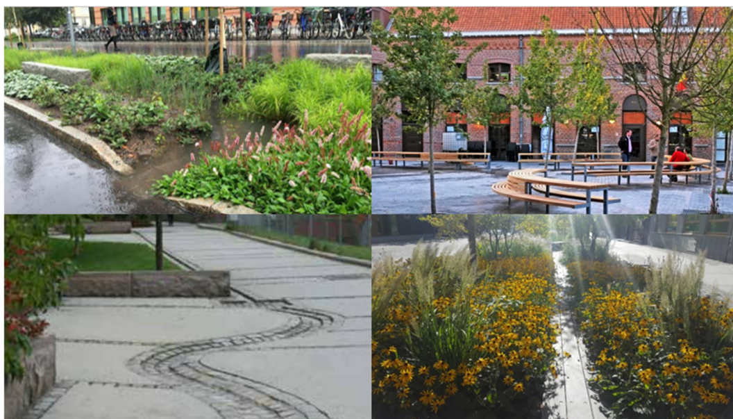
Figur 9. Exempel på nedsänkta växtbäddar (regnbäddar), dagvattenränna samt trädplantering i hårdgjord yta med galler för dagvatteninsläpp.
